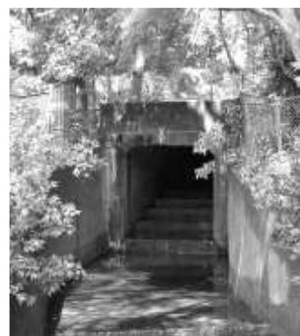
水源2 排水側溝
